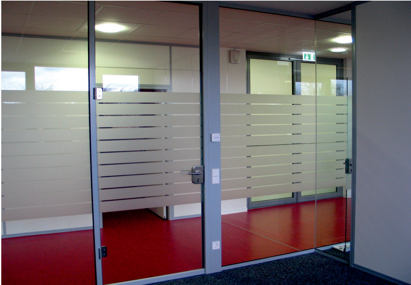
Flurwand mit Tür und Schalterpaneel
