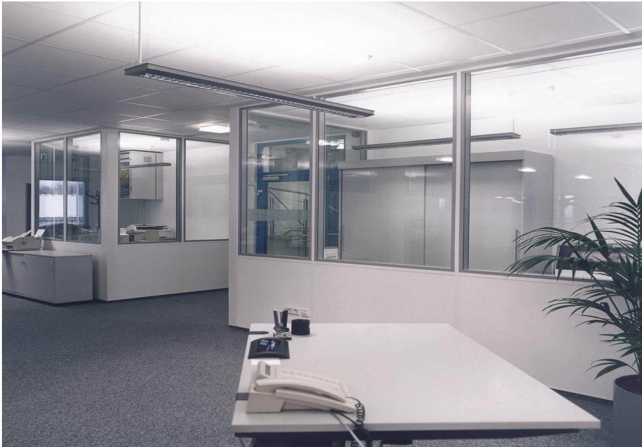
Trennwandeinbau mit Brüstungsverglasung
