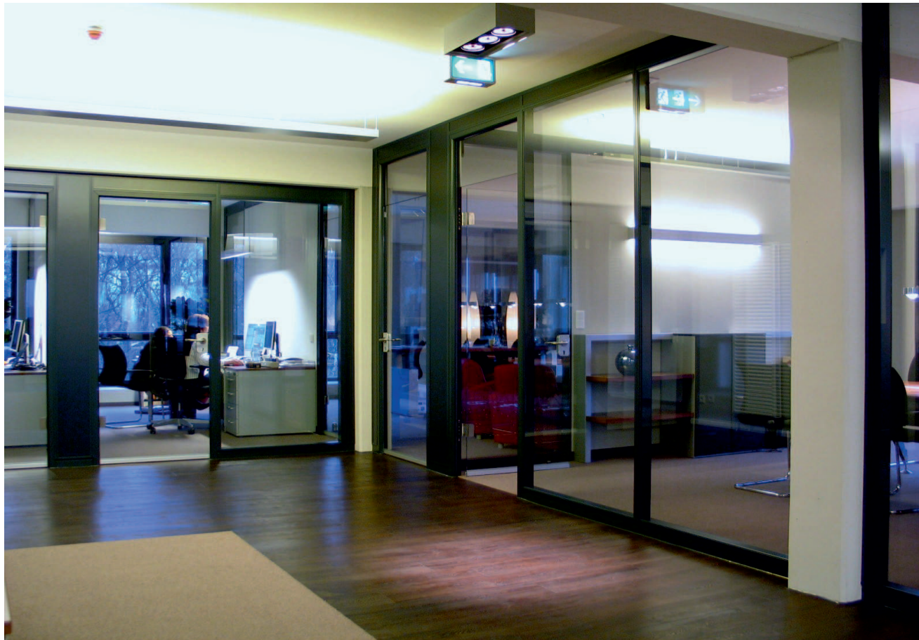
Glaswand als Flurtrennwand
