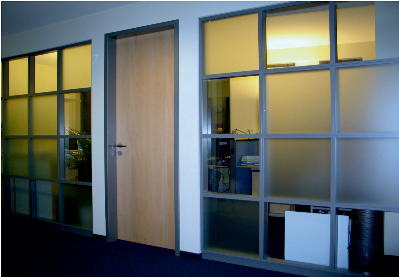
gewürfelte Glaswand in Trockenbauwand
