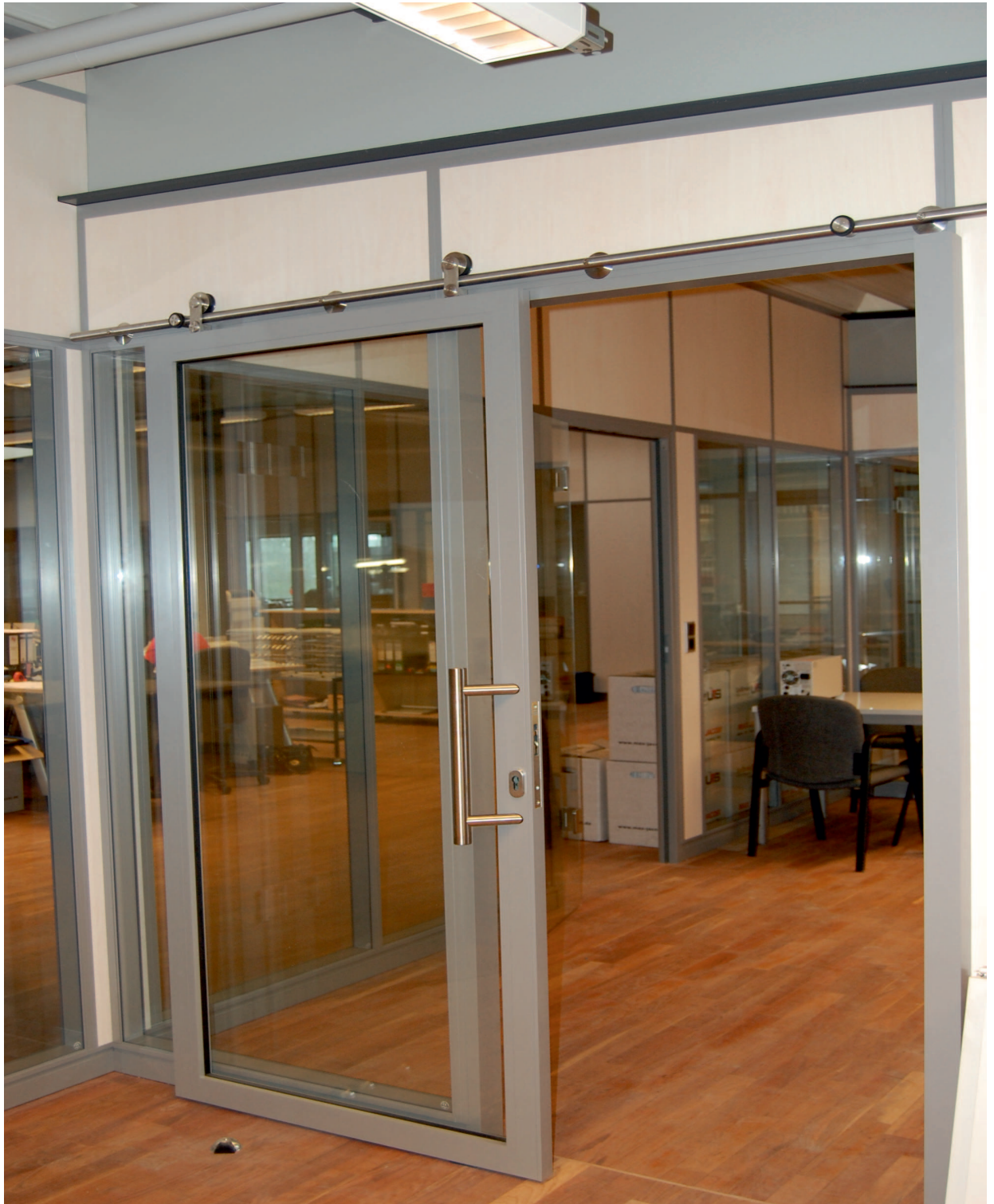
Alurahmenschiebetür mit sichtbarer Laufschiene
