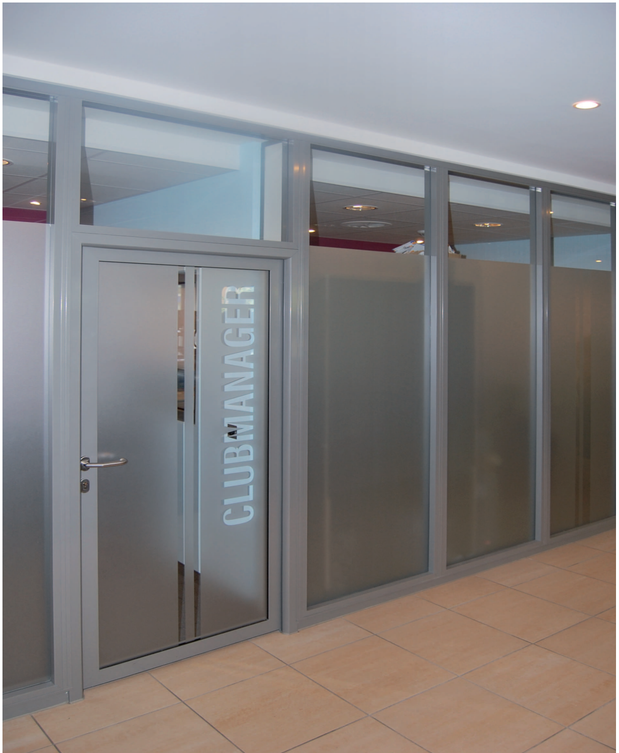
Glaswand mit Aluminiumrahmentür mit Folienbeklebung
