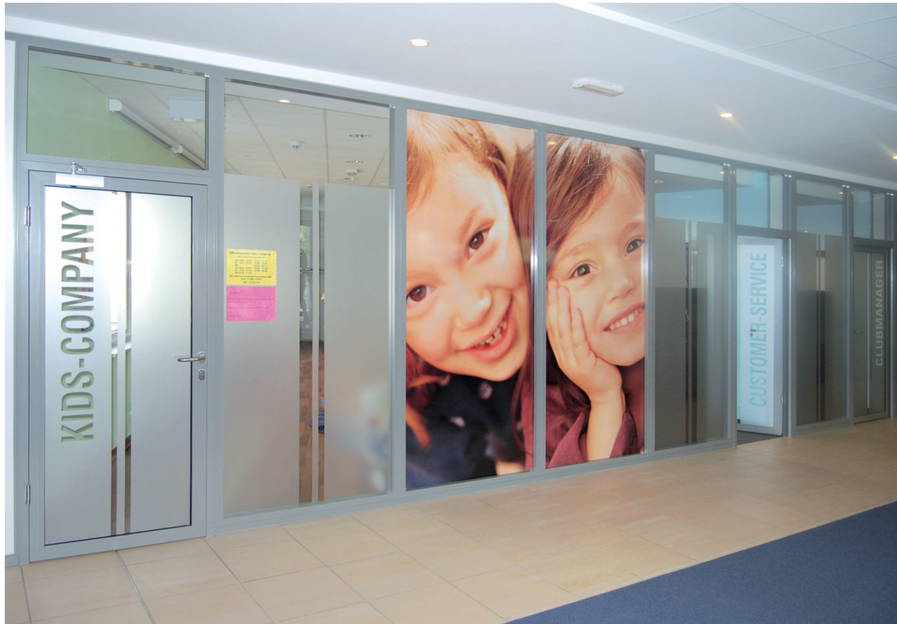
Glaswand mit Folien- technik, Fitneßstudio
