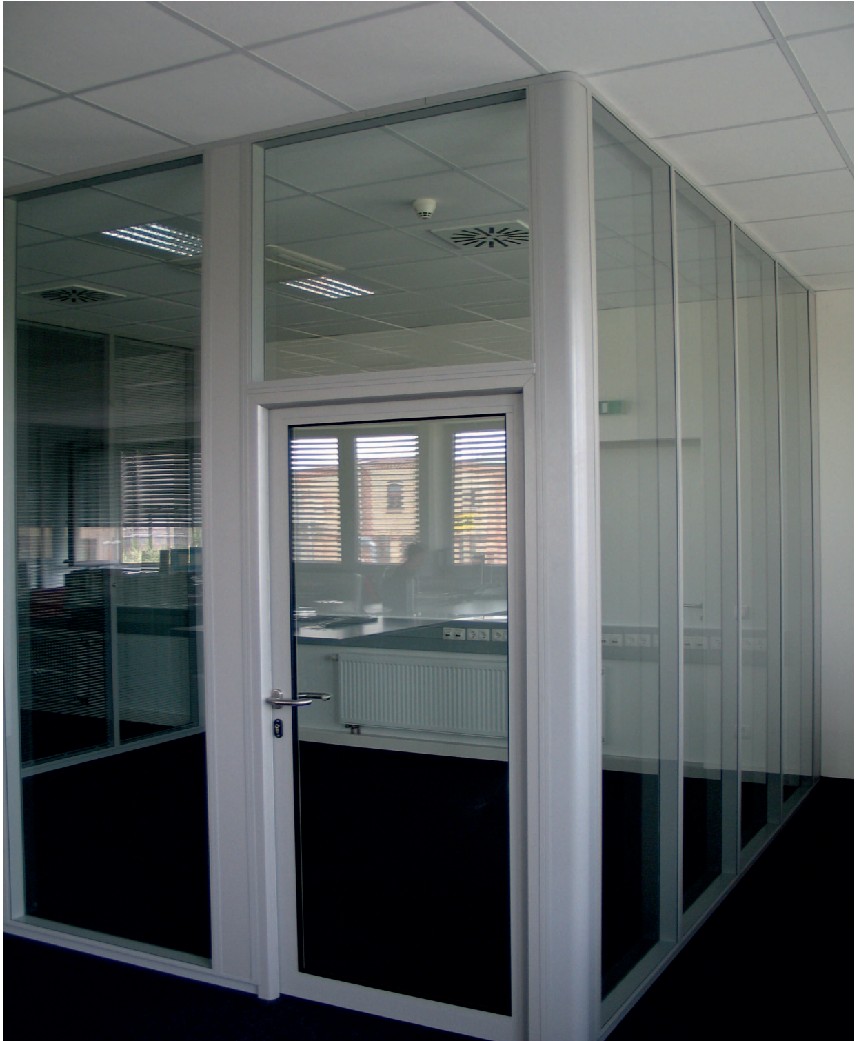
verglastes Büro mit Alu-Rahmentür
