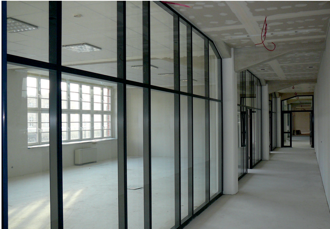
Glaswand mit Schrägverglasung
