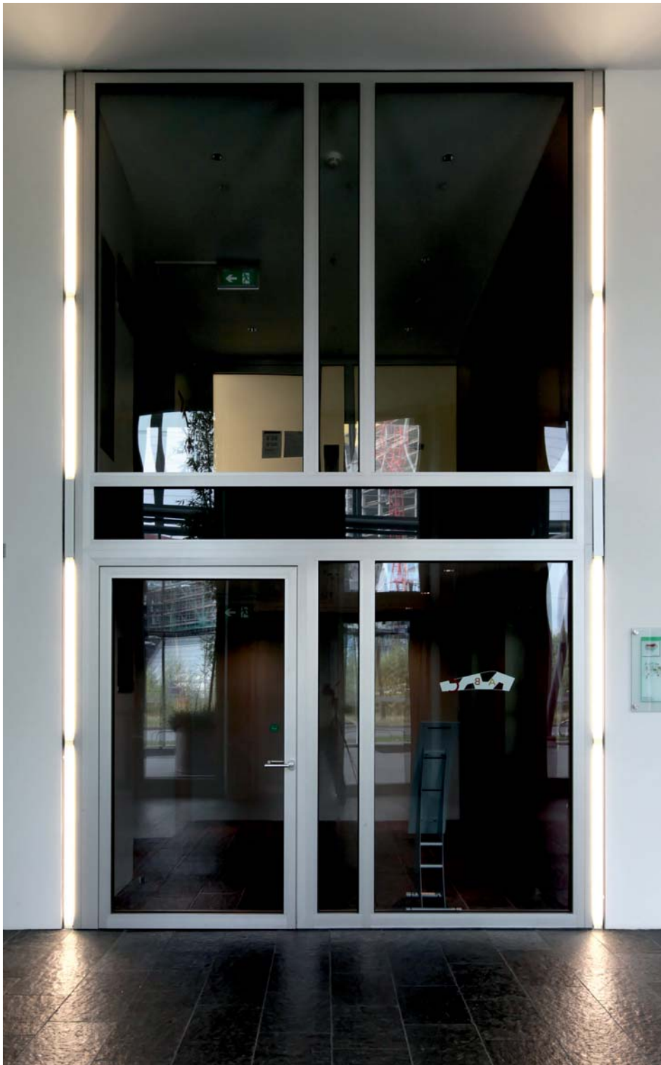
Türanlage T30 mit grossflächiger F30-Verglasung
